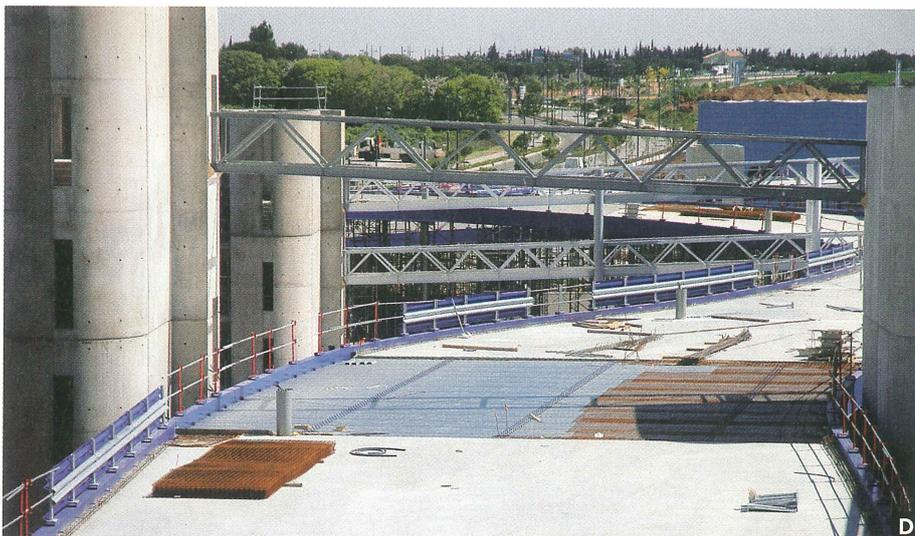
**D** Les composants en acier sont montés et assemblés in situ. Certaines passerelles d'acier, liaisonnant le parking et les noyaux en béton, sont formées de longerons en profilés IPE 360, de solives en HEA 100, espacées de 2,40 m et de tubes de contreventement de 60 mm.
